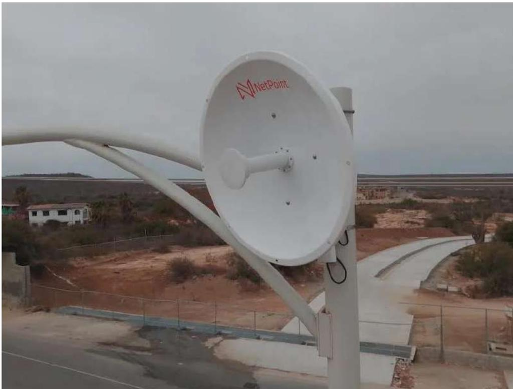
Al estar instaladas en la ciudad costera se tomaron las prevenciones que hay que tener y utilizar los **radomos rompe viento** para ayudar a cortar la resistencia a los posibles golpes de huracanes en esta zona costera de manera adicional se busca brindar protección al feed o dipolo de las degradaciones del espacio libre como son la briza marina o en su caso animales que puedan considerar ¡Hacer de **Netpoint**<sup>®</sup> su casa!.
